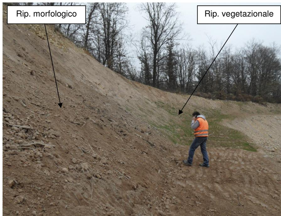
Fig. 4.1 – Panoramica del gradone a quota 408 m s.l.m., con evidenziati i lavori di ripristino morfologico e di ripristino vegetazionale.
