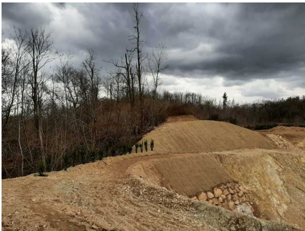
Figura 72 - Operazioni di ripristino vegetazionale con impianto siepe di Lauro nobilis, e inerbimento mediante idrosemina a monte del bacino di decantazione.
