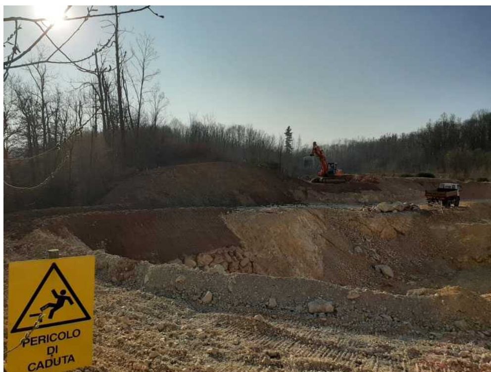
Figura 71 - Operazioni di ripristino morfologico a monte del bacino di decantazione.
