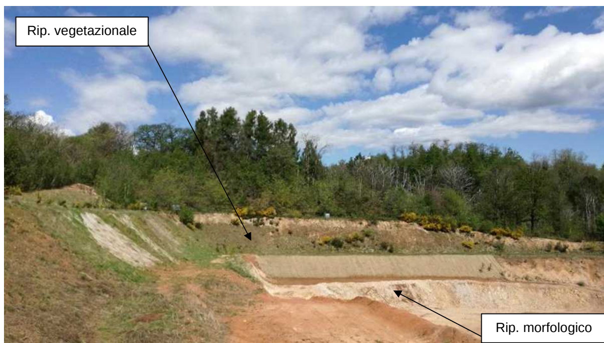
Figura 8 - Panoramica del gradone a quota 405 m s.l.m., con evidenziati i lavori di ripristino morfologico e di ri-pristino vegetazionale.
