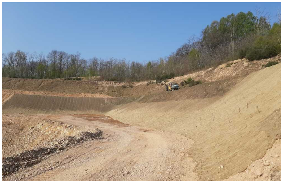
Figura 69 - Operazioni di recupero vegetazionale: 1) operazioni di idrosemina; 2) piantumazione talee.
