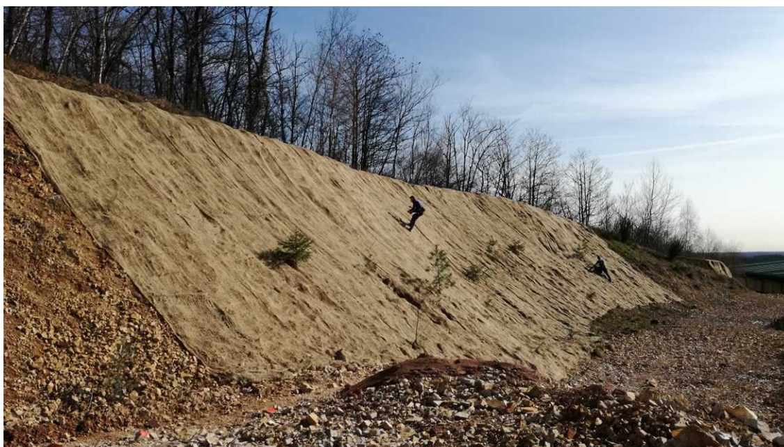
Figura 52 - Posa georete per inerbimento mediante idrosemina.
