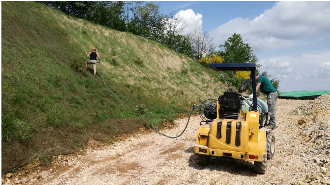
Figura 53 - interventi di idrosemina su scarpate.
