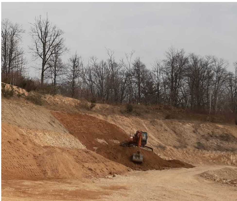
Figura 67 - Operazioni di ripristino morfologico scarpate a N: Riporto sterile – riprofilatura scarpate con angolo massimo di 36° – riporto terreno sterile.
