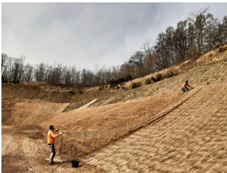
Figura 68 - Operazioni di ripristino morfologico scarpate a N: posa rete iuta biodegradabile.
