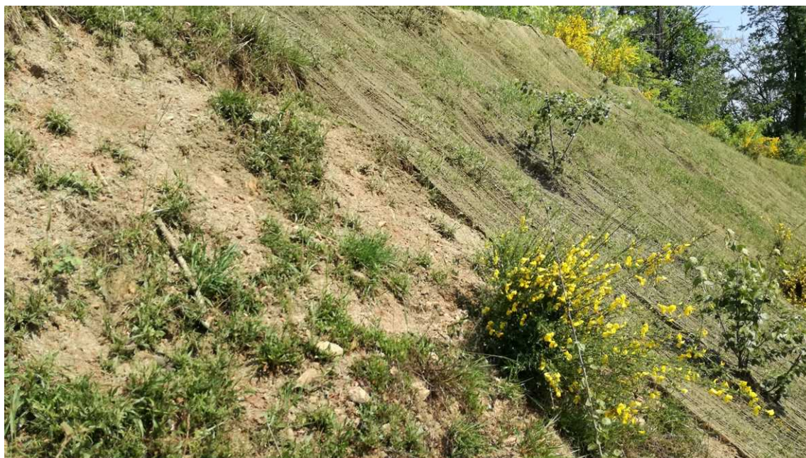
Figura 55 - Risultati ottenuti al termine dell'intervento di recupero lato N.
