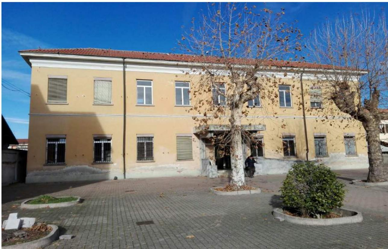
L'edificio risulta avere i muri esterni ed interni in mattoni intonacati, con vernice alle pareti, le finestre al piano terra sono provviste di inferriate, i serramenti sono in alluminio con vetri camera, niente avvolgibili o antoni esterni.
